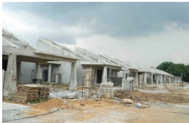
Antara projek perumahan yang masih dalam pembinaan.
